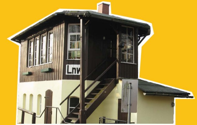
Lüner Damm (Stellwerk)
