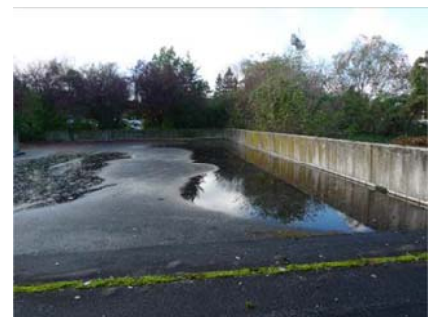
Oberdeck einer Parkpalette
