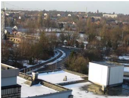
Familienzentrum (links), durch große Straße von Wohnquartier (im Vordergrund) getrennt
