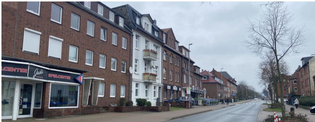
Abbildung 11: Blick entlang der Bleckeder Landstraße in östliche Richtung
